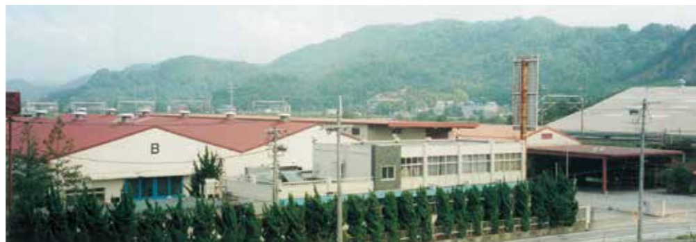
建設当時の彦根工場外景
